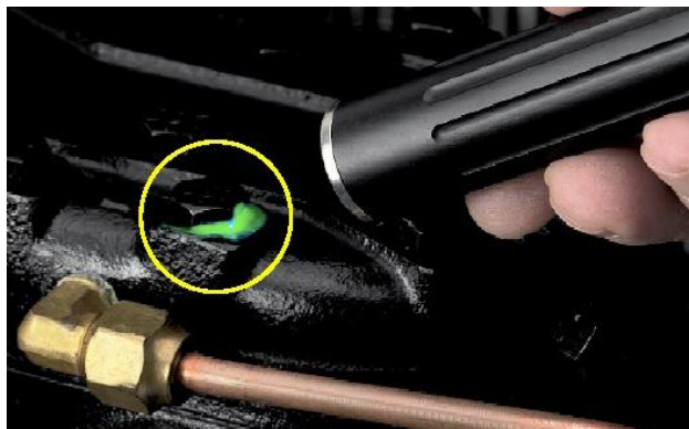
Figura 37 Detección de Fuga por Trazador Fluorescente
