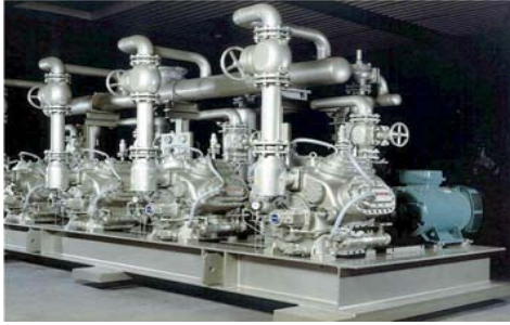
Sala de máquina con varios compresores
